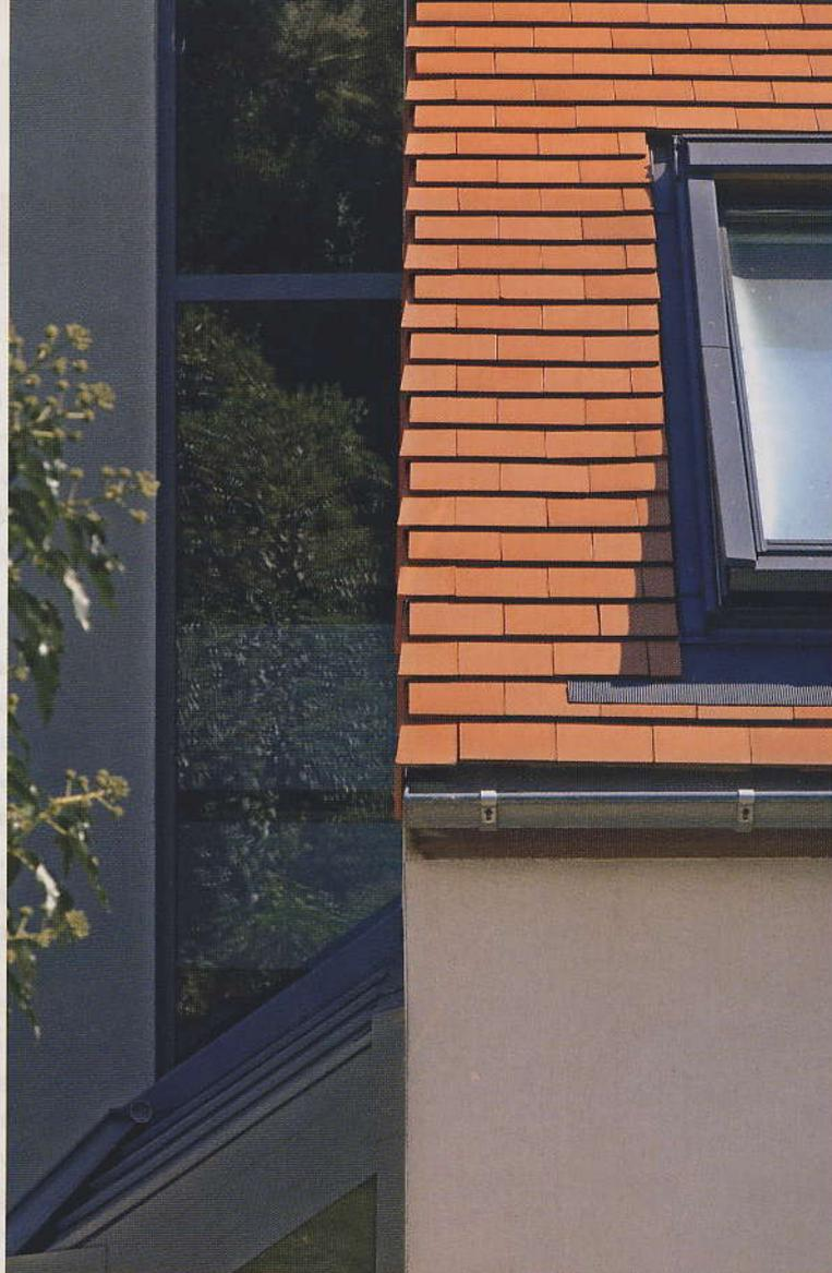
A l'arrière, les tuiles traditionnelles ont été remplacées par des tuiles anglaises plates qui ajoutent une note colorée à la façade.
